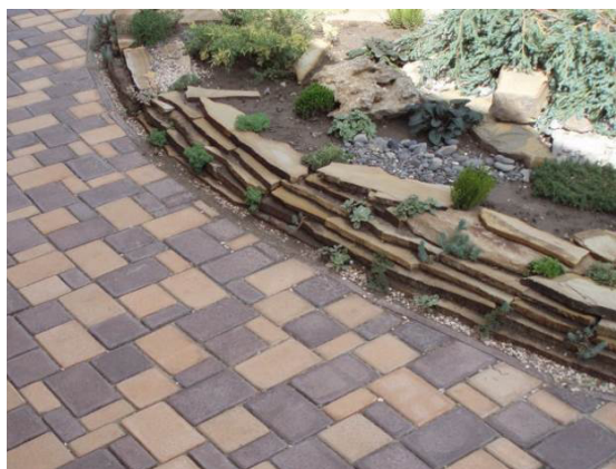
Рис. 7. Приклад мощення садових доріжок у парку та обмеження периметру клумби плитками піскови́ка.
